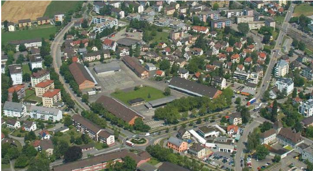
Auf dem Ustermer Zeughausareal werden künftig sowohl Wohnungen als auch Räumlichkeiten für Kultur gebaut.
